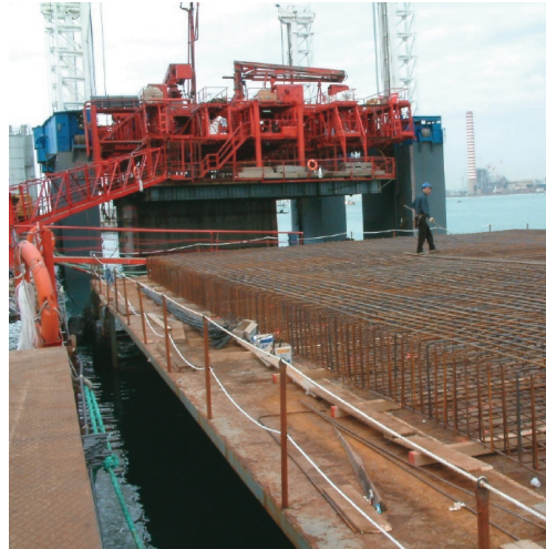
Fig. 2 – Messa in opera dell'armatura.
