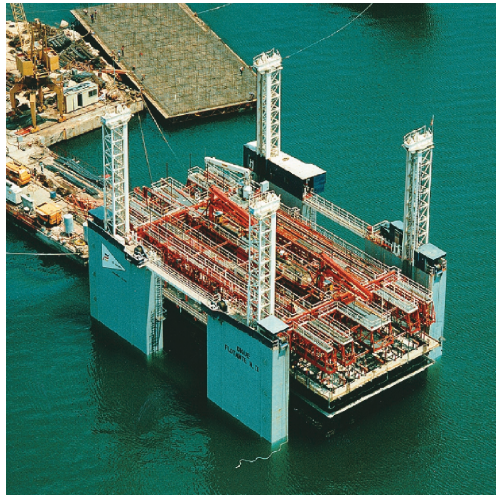
Fig. 1 – Bacino galleggiante utilizzato per la realizzazione dei cassoni.
